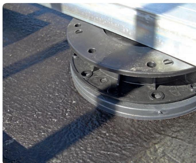
Le testine hanno la funzione di determinare la fuga tra le piastre, variabile da 2,2 a 10 mm.
