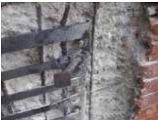
5_ PULIZIA DEI FORI, IMMISSIONE DEL LEGANTE E IMMISSIONE DEI TIRANTI A TESTA A SCOMPARSA
