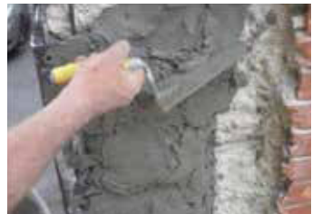
6_ RIPRISTINO DEL COPRIFERRO DI SPESSORE ADEGUATO E RIPRESA DEL RIVESTIMENTO DEL RIVESTIMENTO
