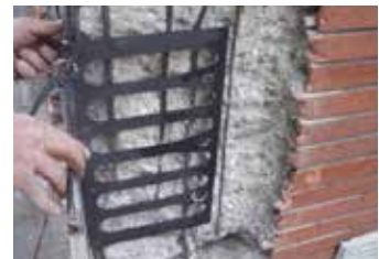
3_ BLOCCAGGIO DELLA MASCHERINA AL FERRO D'ANGOLO TRAMITE LEGATURA
