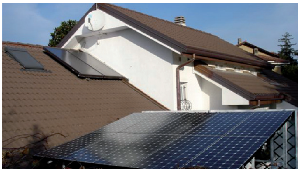
Abitazione con pannelli fotovoltaici e solare termico
