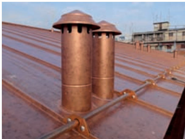
Le infinite possibilità estetiche dell'alluminio. Grazie all'adozione di particolari rivestimenti superficiali, dello spessore di qualche decina di µm, è possibile emulare la resa finale di altri materiali metallici. Nell'esempio qui raffigurato, in particolare, sono state utilizzate lastre in lega di alluminio al 99,5%, trattate sul lato superiore con una speciale verniciatura in grado di riprodurre l'effetto estetico del rame (Nella foto, il sistema di copertura Vestis di Mazzone).
