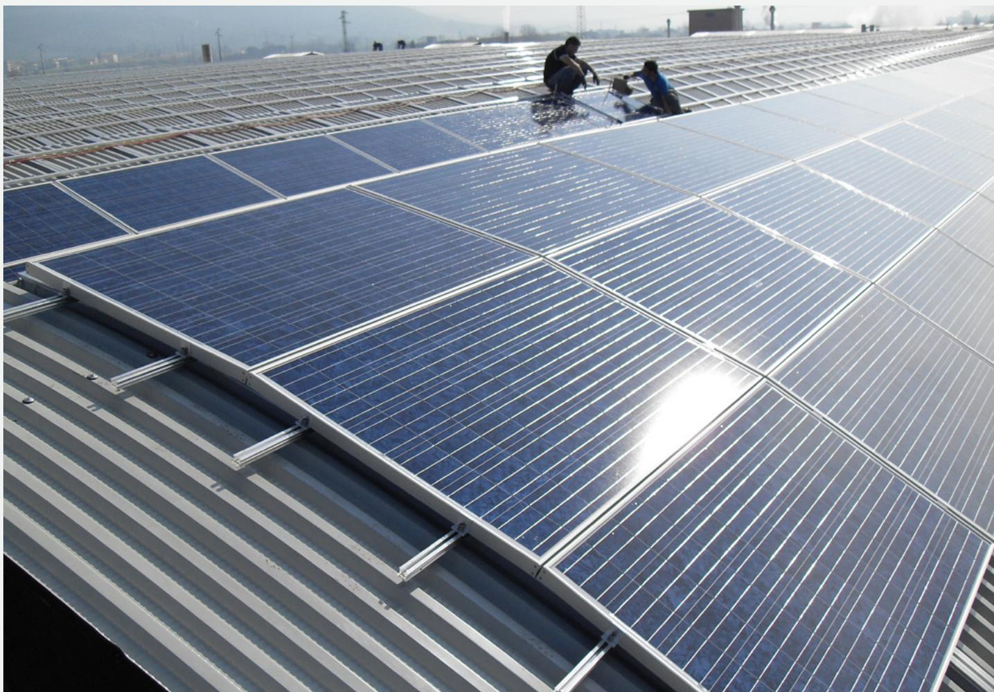
in estruso di alluminio lega EN-AW 6060 opportunamente curvato a seguire la geometria curva della copertura. Successivamente viene applicata una seconda "orditura" composta da un profilo in estruso di alluminio lega EN-AW 6060 opportunamente sagomato ed ancorato al primo mediante innovativo sistema di dilatazione.
