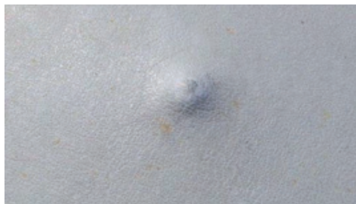
"Pull out", fasi di estrazione del fissaggio dalla faccia superiore di un supporto in lamiera sandwich di basso spessore, a causa delle continue sollecitazioni del vento.
