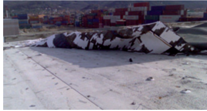
"Pull through" - estrazione da vento di un sistema di copertura vincolato con fissaggio meccanico
