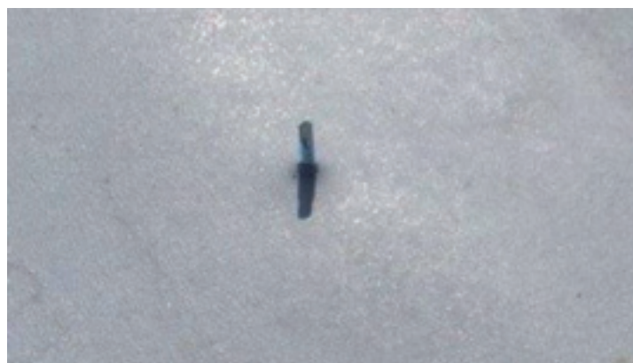
"Pull out", fasi di estrazione del fissaggio dalla faccia superiore di un supporto in lamiera sandwich di basso spessore, a causa delle continue sollecitazioni del vento.
