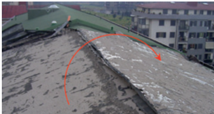
Ribaltamento "a libro" della falda sull'altra, su una copertura a doppia pendenza impermeabilizzata, con membrane in bitume polimero, a causa del piano di posa cementizio assolutamente incoerente e sabbioso
