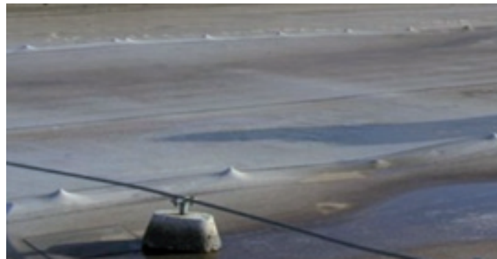
"pull out" estrazione del fissaggio dalla faccia superiore di un supporto in lamiera "sandwich" a basso spessore (0,60 mm), a causa delle continue sollecitazioni d'estrazione da parte del vento; Notare come il telo di membrana sintetica al momento della fotografia non si era ancora forato)
