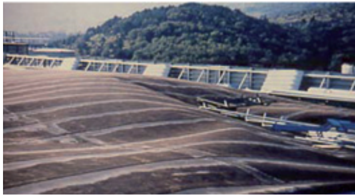
Vista di una copertura, nell'istante in cui lo strato impermeabile viene sollevato, per azione d'estrazione da vento
