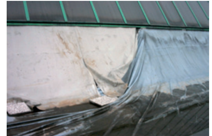
Estrazione da vento su elemento di tenuta, distaccatosi dal supporto, a causa di non corretto incollaggio a fiamma della membrana (rari punti d'adesione), in bitume polimero, sul pannello termoisolante.
