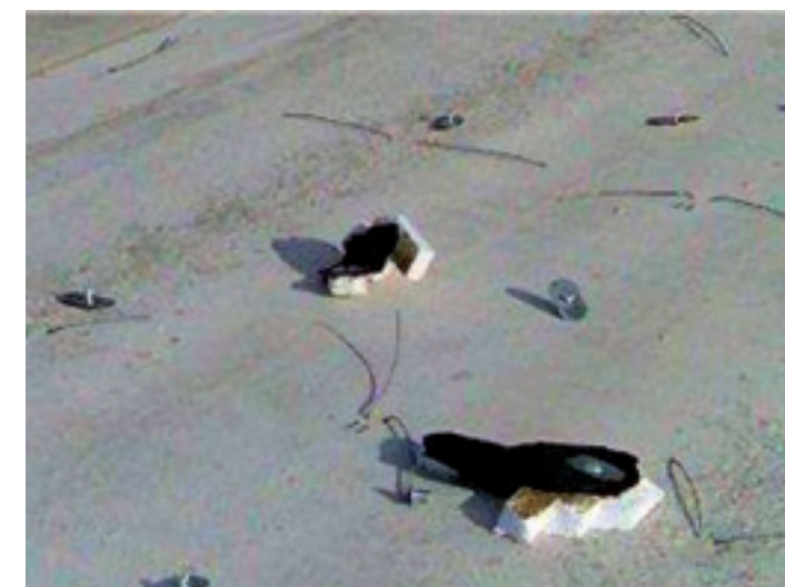
"Pull through" cedimento e rottura del pannello e della membrana accoppiata (bitume polimero, armata con velo di vetro), sotto l'azione d'estrazione da vento. Si nota come la membrana accoppiata al pannello termoisolante si sia lacerata intorno alla parte di pannello rimasta ancora sotto il fissaggio.
