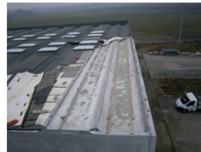
"Pull through" - estrazione da vento di un sistema di copertura vincolato con fissaggio meccanico
