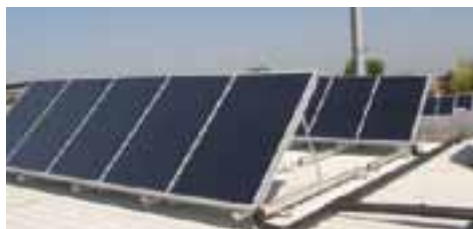
Impianto solare termico, Comune di Bra (CN)
