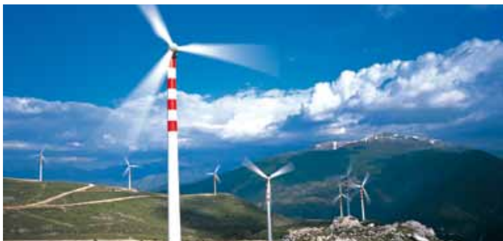
Impianto eolico Comune di Cocullo (AQ)
