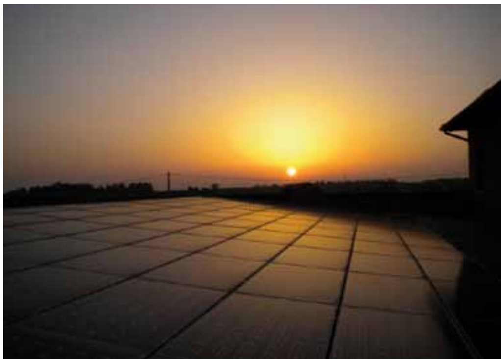
Impianto fotovoltaico Tenuta Menfi (AG)
