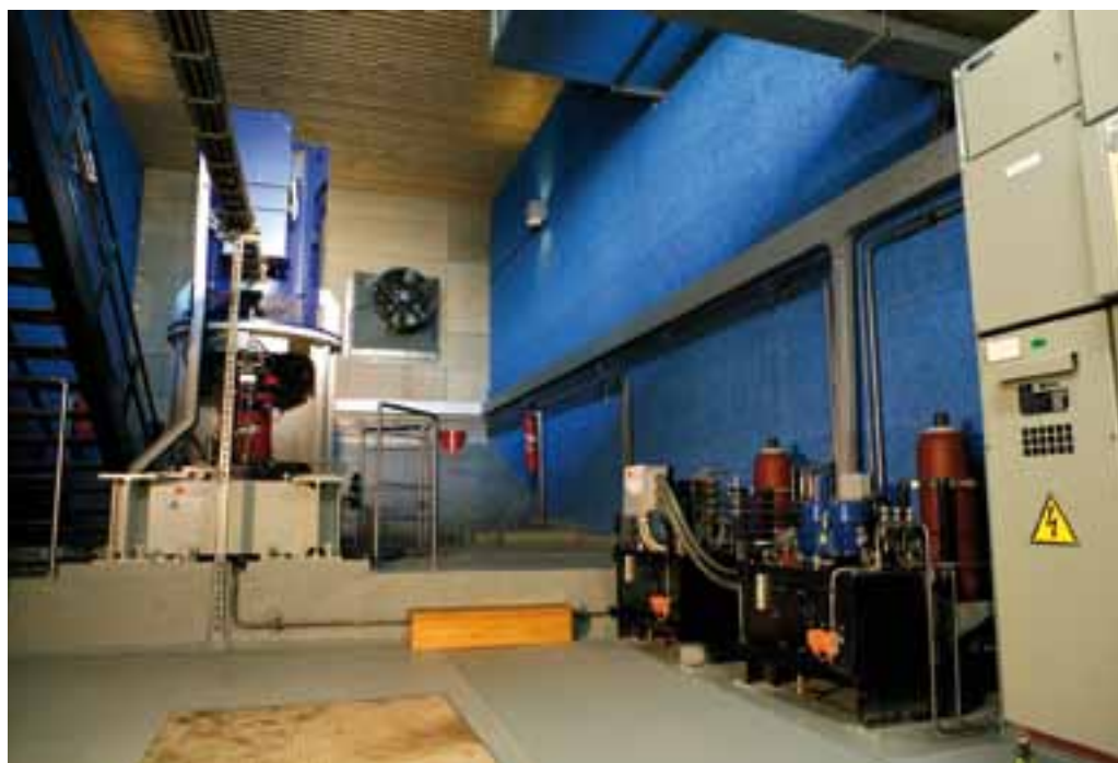
Impianto idroelettrico Envirometal Park (TO)
