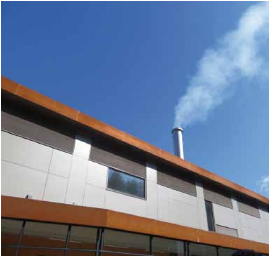
Impianto a biomassa Comune di Dobbiaco (BZ)
