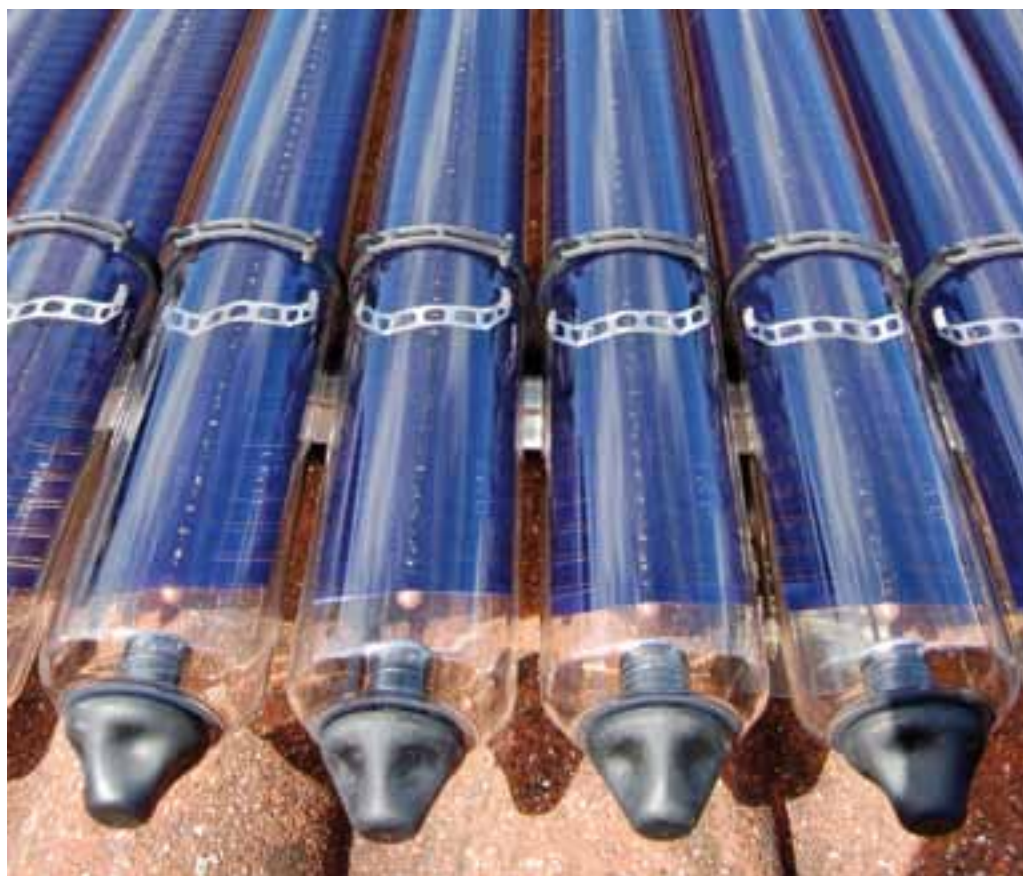
Particolare di un pannello solare termico
