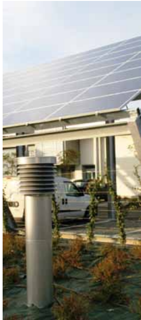
Impianto solare fotovoltaico su pensilina, Comune di Conselice (RA)
