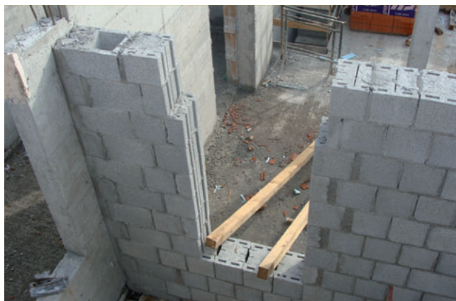
Quando alleggerito non significa meno solido: nell'esempio qui raffigurato, il blocco è ottenuto da un impasto di cemento e vetro espanso di riciclo che conferisce all'elemento un ottimo comportamento sia termico che acustico. Al tempo stesso, nonostante il peso ridotto, il blocco è portante e consente di realizzare edifici di due/tre piani fuori terra senza tradizionali travi e pilastri, con notevoli vantaggi dal punto di vista delle prestazioni termiche complessive (M.V.B.).
