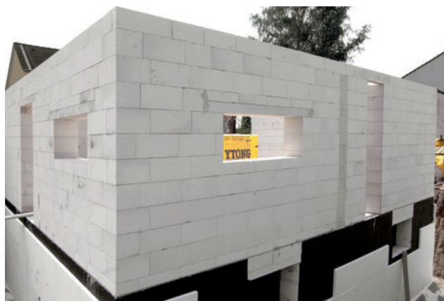
Il calcestruzzo cellulare autoclavato è un ottimo isolante termico sia nel periodo estivo sia in quello invernale grazie alla elevata resistenza termica e un coefficiente di conducibilità termica decisamente basso. Grazie a tali proprietà i blocchi di questa tipologia consentono di realizzare pareti con prestazioni termiche di alto livello senza ricorrere a materiali isolanti aggiuntivi (Xella).
