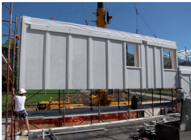
Posa di pannello parete in realizzazione multipiano. Il pannello del tipo ARIATM rappresenta un innovativo sistema per la realizzazione di pareti miste in legno-calcestruzzo preassemblate in stabilimento, che garantiscono agli edifici un elevato comfort ambientale, grazie all'ideazione all'interno dei tamponamenti esposti e delle coperture, di una camera d'aria continua che avvolge lo spazio abitativo. Il pannello è quindi costituito da una struttura interna intelaiata in legno e da una lastra esterna in calcestruzzo ad essa connessa, con contemporanea presenza anche di un elevato spessore di isolante. Le sue caratteristiche di posa sembrano quasi far rivivere i fasti delle costruzioni prefabbricate anni '70, in chiave decisamente più tecnologica e di elevate prestazioni da parte del complesso della costruzione (Wood Beton).
