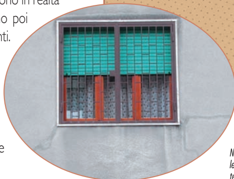
Tipico quadro fessurativo sulle facciate di un immobile causa adiacente scavo
