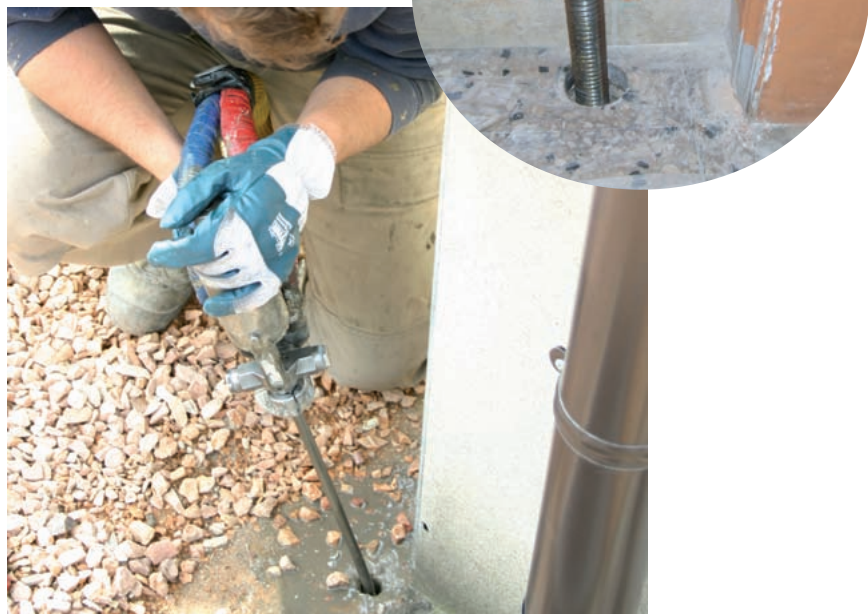
Esempi delle fasi esecutive di consolidamenti di fondazioni mediante tecnica di iniezioni di resina espandente nel terreno con successiva integrazione di micropali d'acciaio (foto Novatek)
