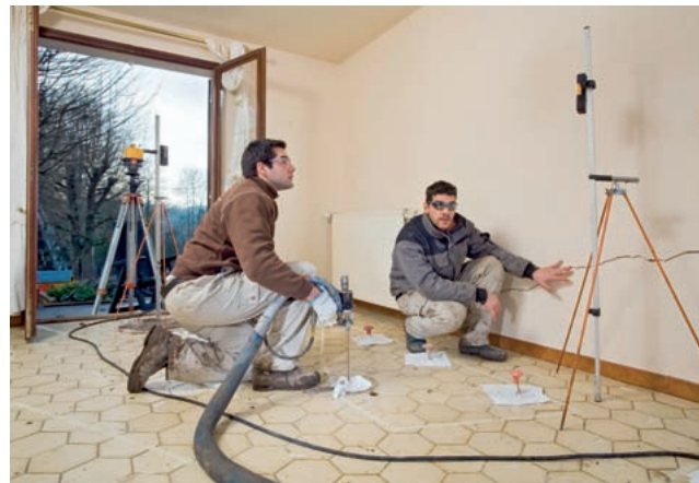
Nella foto esempio di consolidamento mediante iniezione con resine espandenti e relativo controllo della planarità della pavimentazione (Uretek)
