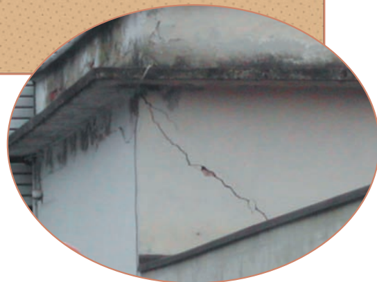
Nella foto: tipica lesione a 45° su un edificio in muratura causa cedimento locale del terreno
