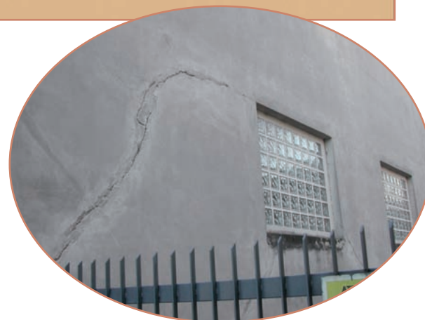
Nella foto: fessura ad arco. Tipica dimostrazione del cedimento del terreno sotto alla parte centrale della costruzione
