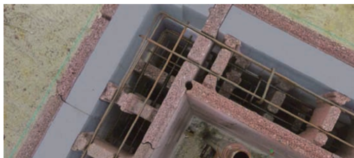
Sistema costruttivo Bioplus – antisismico con blocchi cassero ad incastro (Paver)
