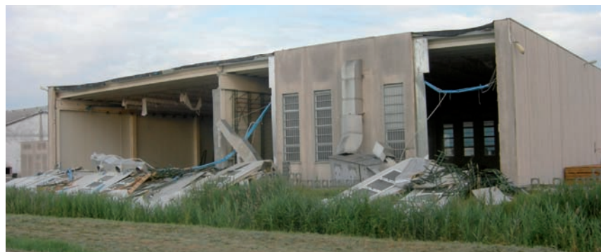
Post-sisma: errata connessione tra elementi prefabbricati
