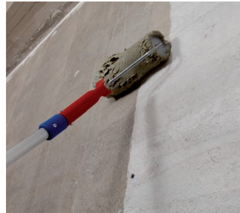
Nella foto un esempio di consolidamento di una muratura interna di un edificio mediante l'applicazione di MapeVWrap EQ System. Si tratta di un sistema composto da due prodotti, un'adesivo monocomponente all'acqua a base di dispersione poliuretanica e di un tessuto bidirezionale in fibra di vetro. La sua applicazione sulle pareti, che può avvenire anche direttamente su intonaco esistente, aumenta il tempo di evacuazione dall'edificio in caso di sisma. Il prodotto è inodore e ha uno spessore di circa 1mm. (Mapei)
