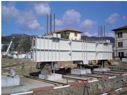
Prova di carico su pali.
