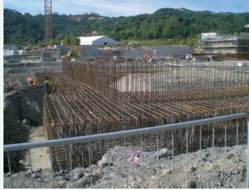
Armatura platea di fondazione
