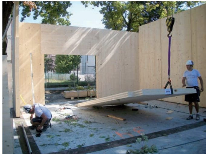
Inizio settembre 2012: trasporto e montaggio pannelli di parete.
