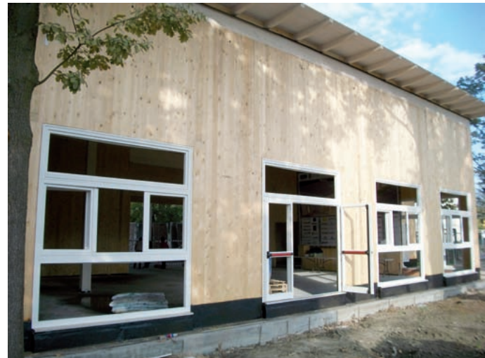
Ottobre 2012: completamento della struttura portante dell'intero complesso.
