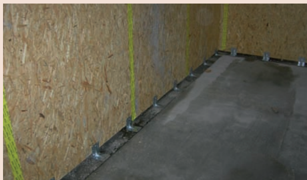
Squadrette di fissaggio meccanico alla fondazione per assorbimento di azioni di taglio
