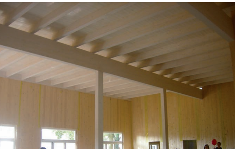
Atrio d'ingresso dell'edificio.
