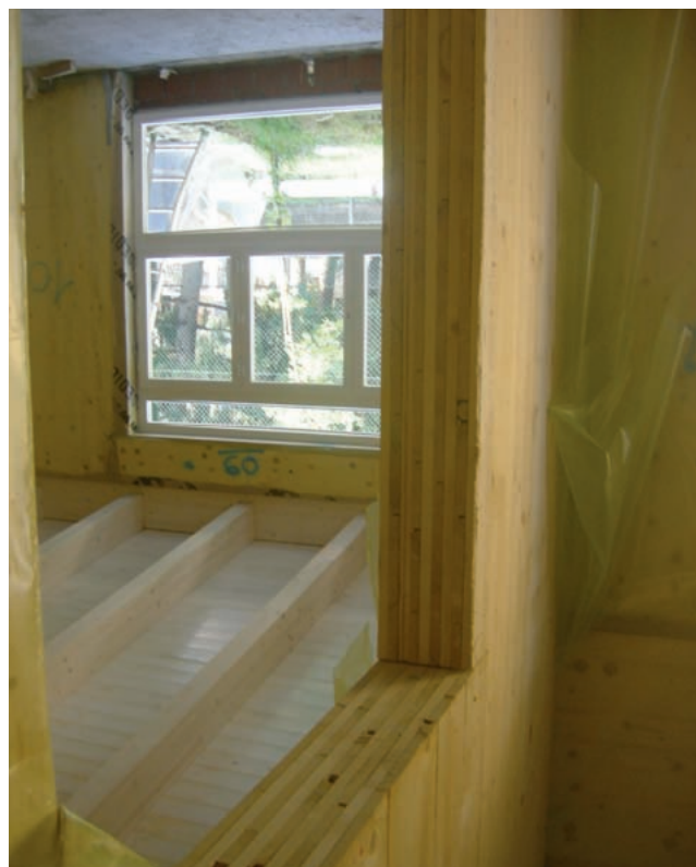
Parete realizzata con sistema costruttivo X-Lam.
