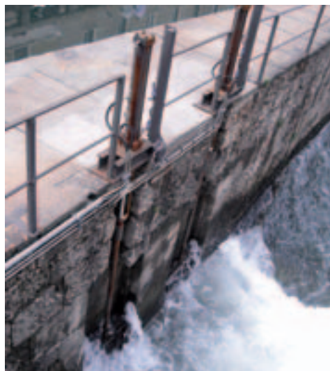
Impianto mini idroelettrico, Comune di Milano
