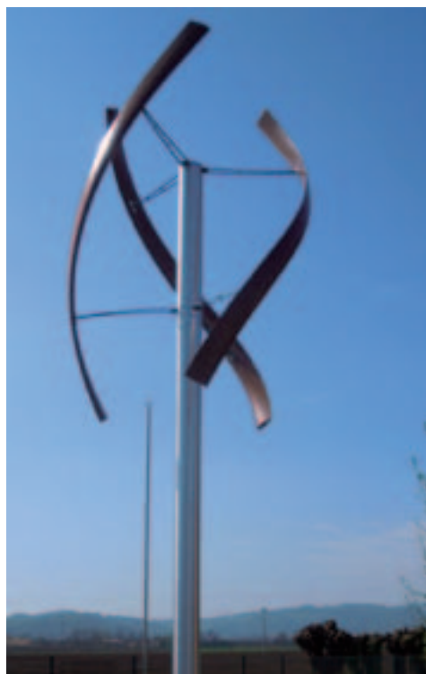
Impianto mini eolico, sede azienda privata nel Comune di Vicenza
