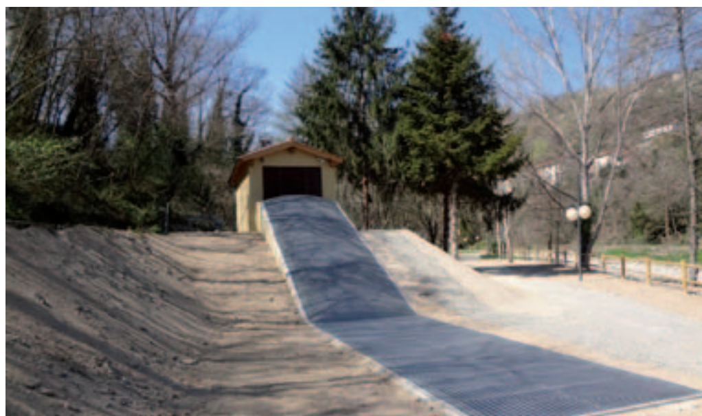
Impianto mini idroelettrico, Comune di Prato
