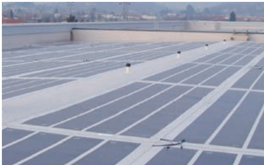
L'ultima evoluzione: l'integrazione nei manti impermeabili di film fotovoltaici per la produzione di energia.
