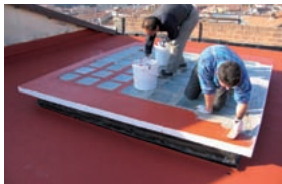
Gli impermeabilizzanti liquidi: alternativa efficace e particolarmente interessante per la sua attitudine a risolvere agevolmente dettagli costruttivi complessi.
