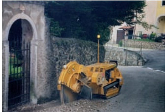
Anche l'esecuzione di trincee in banchina, pur se a raso muro, diventa agevole grazie alla possibilità di traslare lateralmente in disco di scavo (Garbin).
