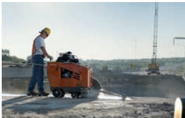
Crescono le dimensioni, crescono le applicazioni: le attrezzature a disco diamantato trovano impiego non solo nel taglio dell'asfalto ma anche su superfici in calcestruzzo (Husqvarna).
