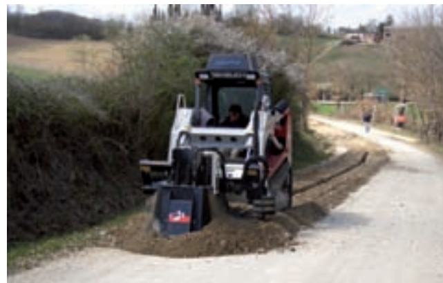
Una soluzione di grande praticità: l'escavatrice a ruota, in grado di eseguire in contemporanea taglio, scavo e rimozione del materiale fresato. In assoluta sicurezza, grazie al telaio che racchiude la ruota (Simex).
