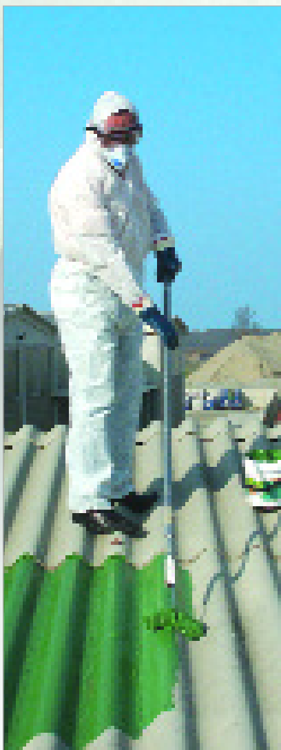
FIG. 1 Applicatore in cantiere. Lastre poggianti su soletta in CLS
