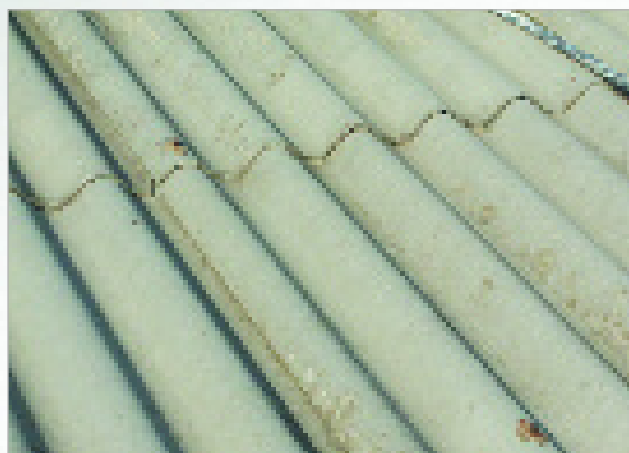
FIG. 2 Lastra eternit prima dell'incapsulamento
