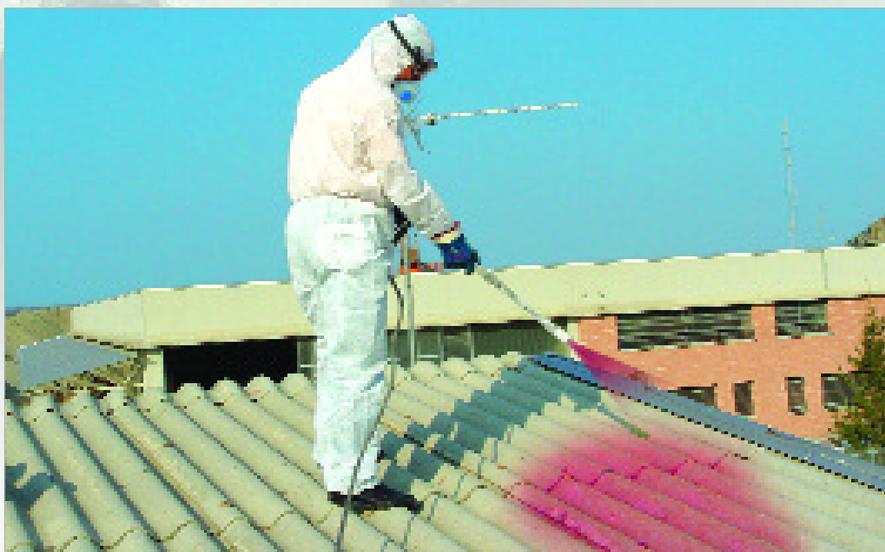
FIG. 8 Trattamento funzionale alla rimozione mediante fissativo acrilico. Punto D
