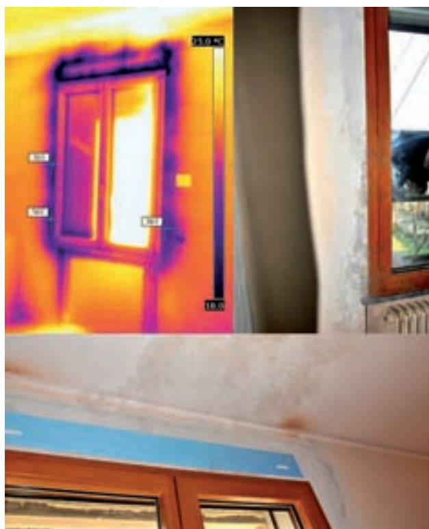
◀ Ponte termico dovuto alla mancanza di isolamento tra telaio e controtelaio.
